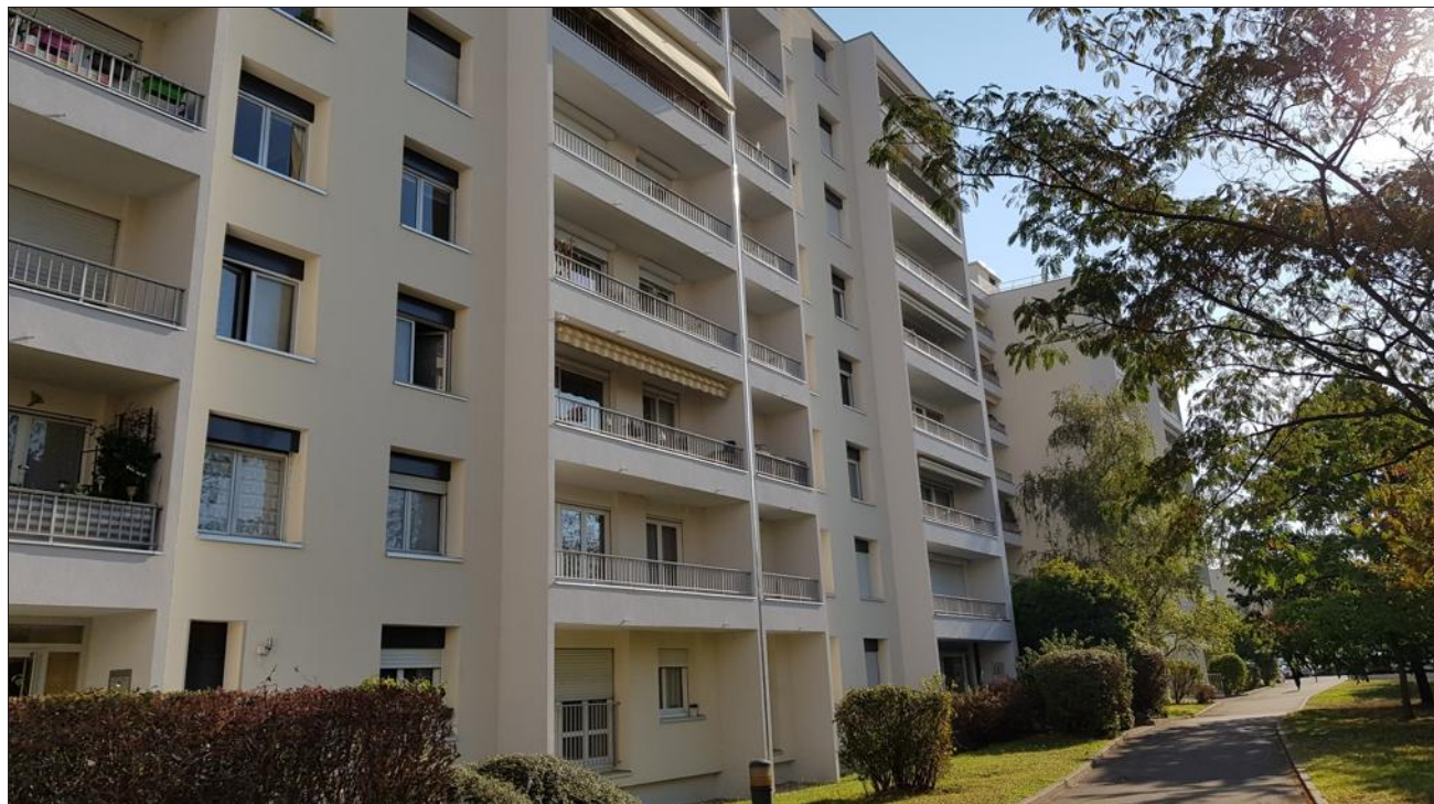
■ Le projet en réflexion depuis 2012 résidence des Frères Lumières a abouti à une rénovation BBC du plus bel effet : isolation des façades et des toitures, remplacement des chaudières et ravalement des façades. Photo Nadine MICHOLIN
