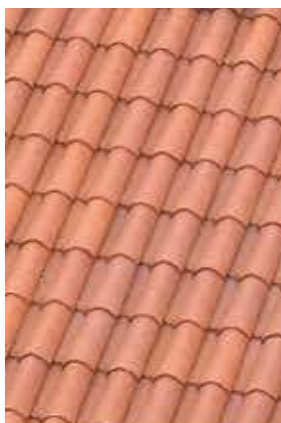
Toiture de tuiles romanes
