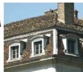
Toit « à la Mansart » en tuiles plates
