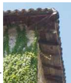
Forget débordant ancien, sans gouttière
