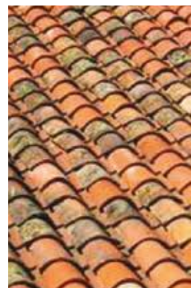
Toiture de tuiles creuses
